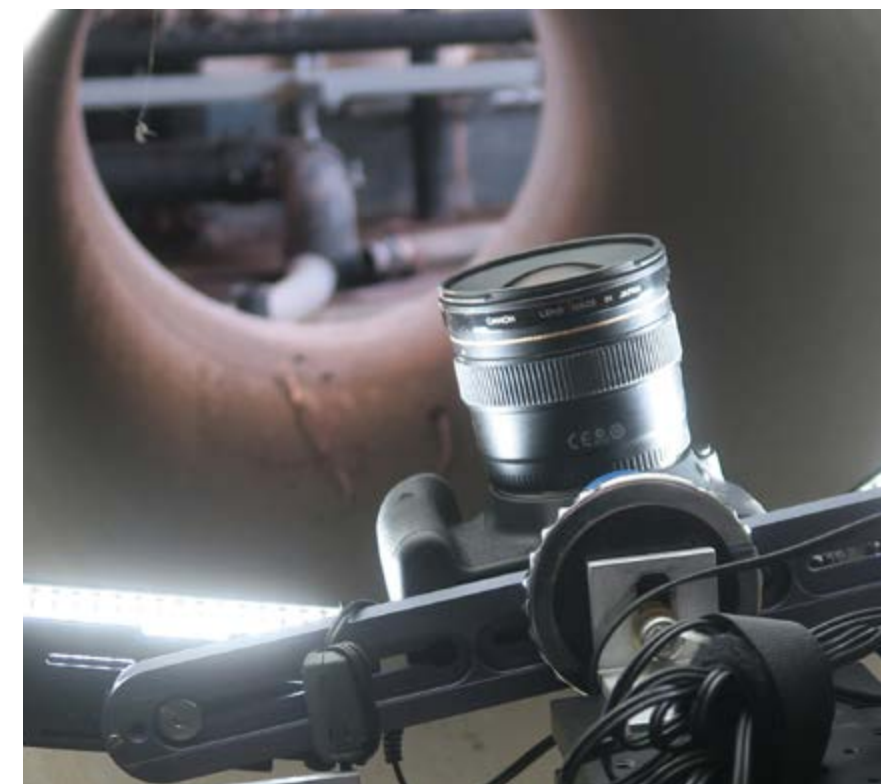
Ein Testsystem zum Kamerakopf im Einsatz: Kameraroboter mit hochauflösender Bilderfassung sollen im Berliner Kanalnetz zunehmend Realität werden.
