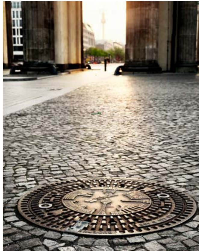
Mehr als 200.000 Einstiegsschächte dienen als Zugang zu den hauptstädtischen Abwasserkanälen.
