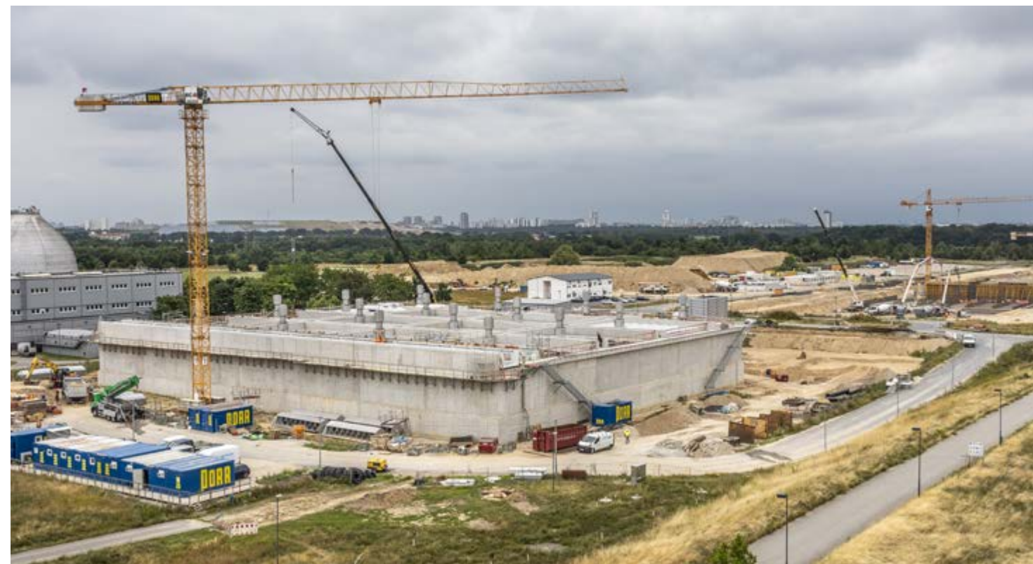
Der Ausbau des Klärwerks Waßmannsdorf ist das derzeit größte Investitionsprojekt der Berliner Wasserbetriebe.
